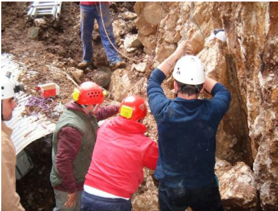
Continua l'opera di disostruzione
